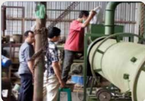
Running test mesin pellet pada pabrik pelletisasi.
