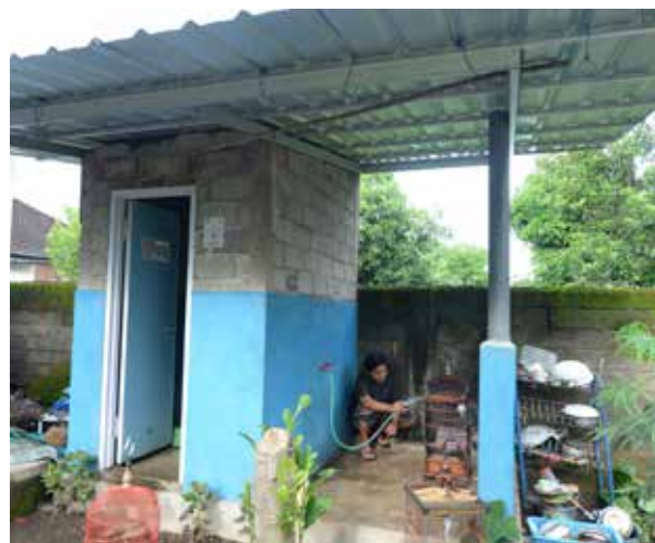
Bantuan pembangunan 400 MCK di 8 Kabupaten di Nusa Tenggara Barat
